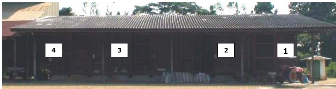
ภาพที่ 4-1 การติดตั้งแผ่นป้ายที่คลังข้าวสาร (ก่อนติดตั้ง)
