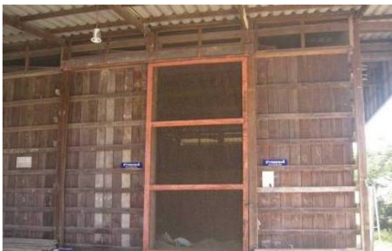
ภาพที่ 4-2 การติดตั้งแผ่นป้ายที่คลังข้าวสาร (หลังติดตั้ง)
